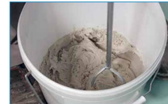
Prin adăugarea componentelor atent cântărite, materialul trebuie amestecat până la obținerea unei mase uniforme, fără aglomerări.
