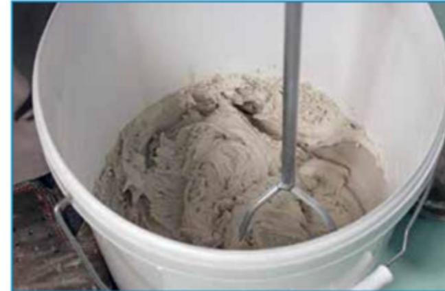
Prin adăugarea componentelor atent cântărite, materialul trebuie amestecat până la obținerea unei mase uniforme, fără aglomerări.
