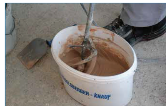
Chitul de rosturi se amestecă până la omogenizare prin adăugarea de apă măsurată cu exactitate.
