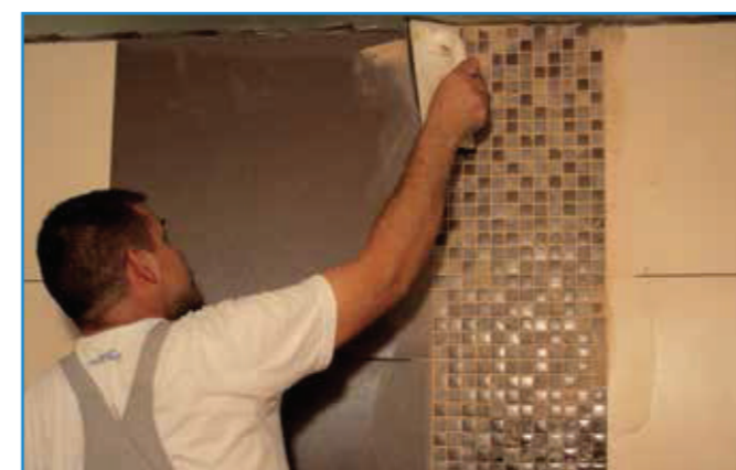
Mortarul de rosturi se aplică cu un șpaclu specială de rostuit, din cauciuc.
